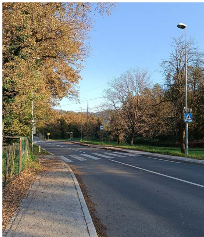
Urejen pločnik in prehod za pešce v Gorici pri Moravčah. (foto: LUZ, d.d.)
