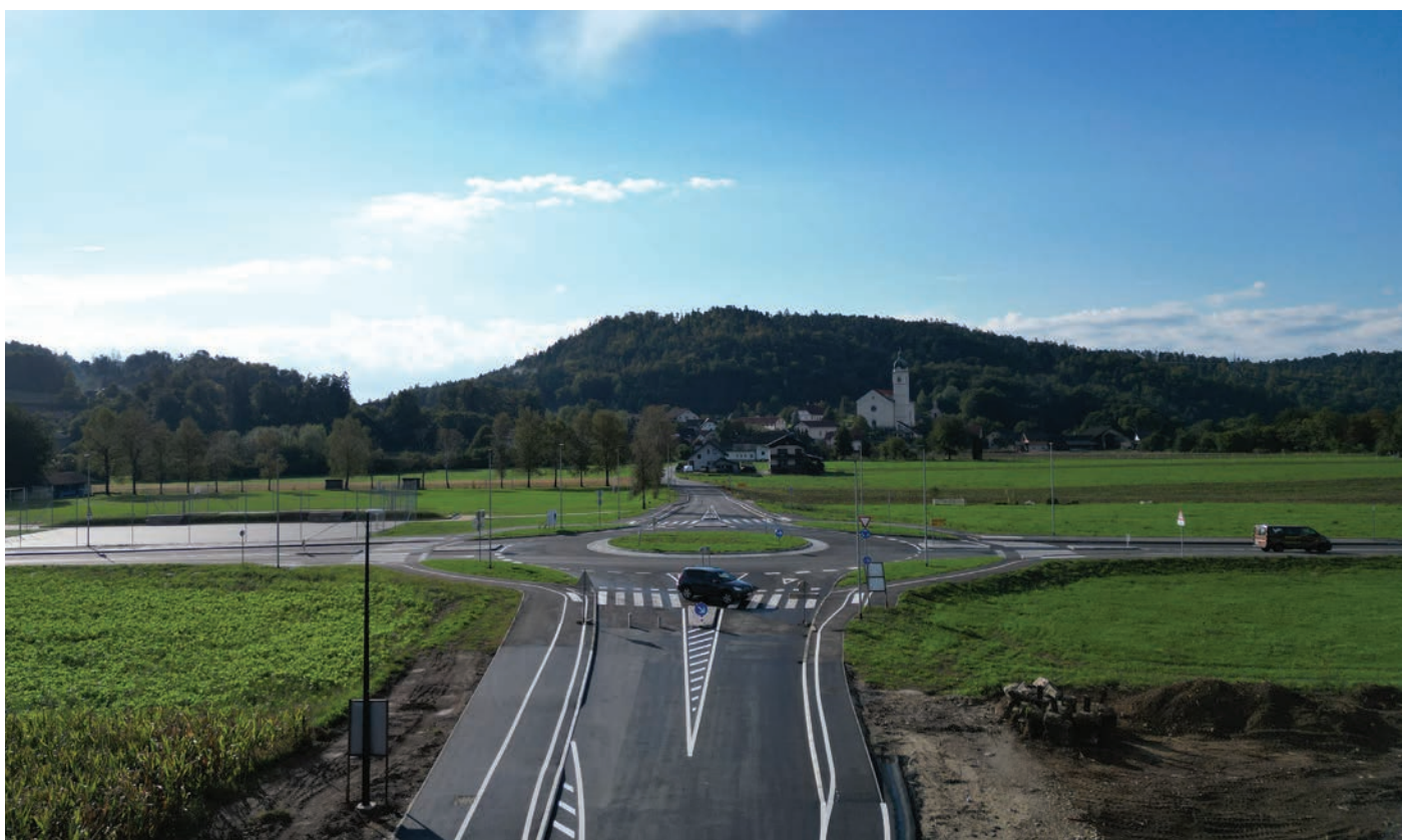
Nova prometna ureditev v Smledniku (avtor: Grabec Borut)
