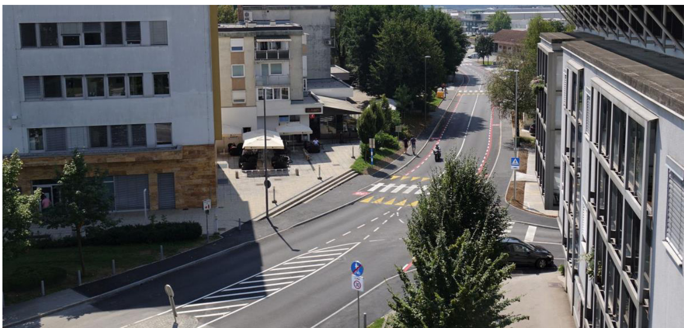
Celovito obnovljena Taborska cesta v Grosuplju (foto: arhiv Občine Grosuplje)
