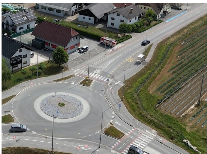
Obnovljena cesta in novo krožno križišče v Velikem Mlačevem (foto: arhiv Občine Grosuplje)
