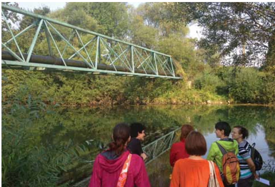
Vodovodni most čez Ljubljanico v Črni vasi
